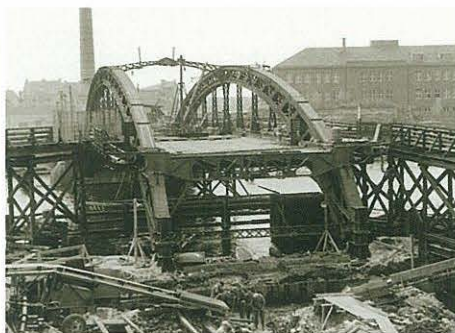
Grundinstandsetzung bzw. Neubau von Brücken über die Spree
