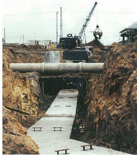
Heizkanalbau (Sohle mit Gleitlager)
