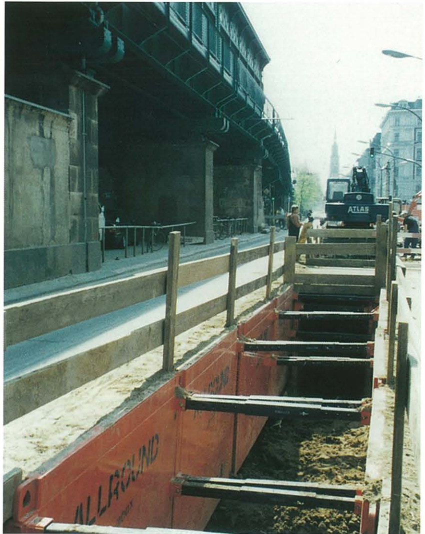
Bau von Entwässerungskanälen in der Schönhauser Allee im Auftrag der Berliner Wasserbetriebe
