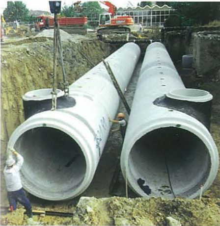
Bau eines Regenrückstaukanals im Storkower Bogen
