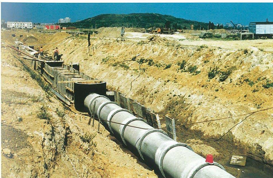
Der tiefliegende Regenkanal aus Betonrohr erhält eine bewehrte Betonummantelung
