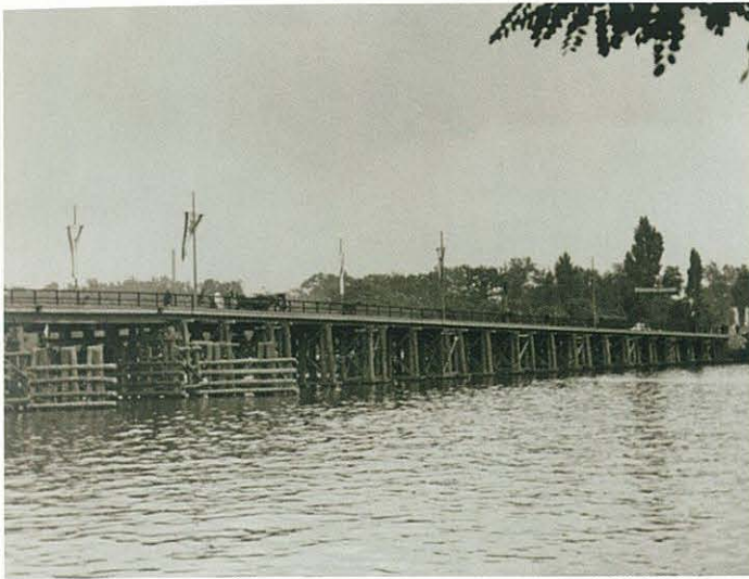
Wiederaufbau der in den letzten Kriegstagen zerstörten Brücken
