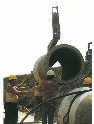
Der tiefliegende Regenkanal aus Betonrohr erhält eine bewehrte Betonummantelung
