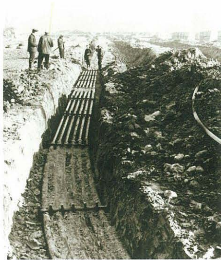
vorgezogene Leerverrohrung für Kabelverlegung
