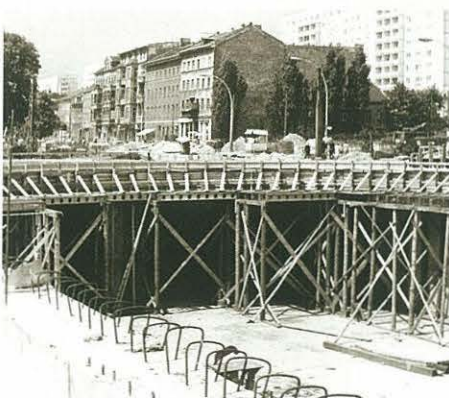
Straßentunnel im Bau (Kreuzungsbereich Alt-Friedrichsfelde – Rhinstraße)
