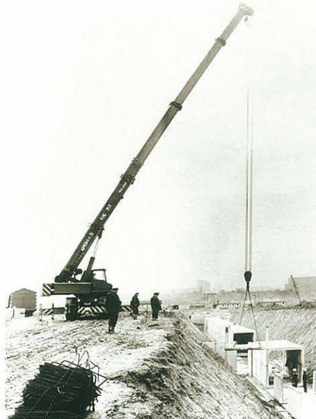
Montage eines Sammelkanals aus Fertigteilen (Trog-Haube)
