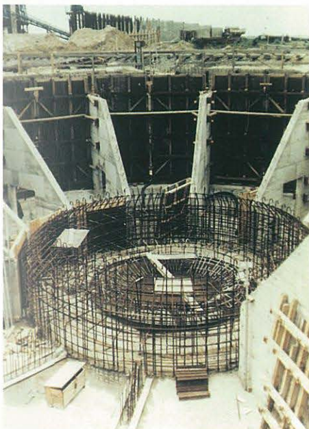
Untere Kegelschale eines Faulbehälters im Bau
